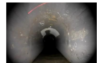
図6 応用例（ロボットやドローンによる擁壁や暗渠の変状検出）
